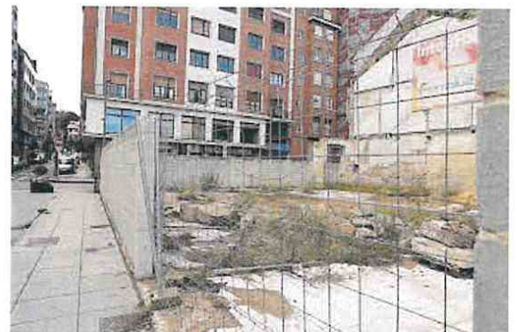
Estado actual del solar, tras el derribo del conjunto original. | M. V.
